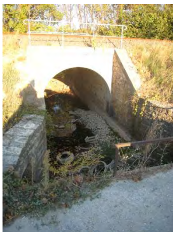
Ouvrage traversant n°5 sous la voie ferrée vu depuis l'aval
