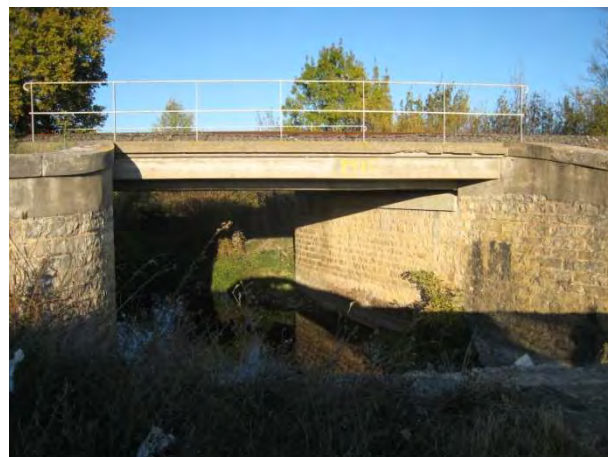
Ouvrage traversant n°2 sous la voie ferrée vu depuis l'aval
