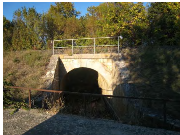
Ouvrage traversant n°6 sous la voie ferrée vu depuis l'aval
